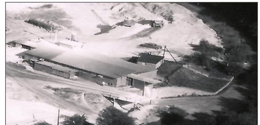
Abb. 50: Anlage zur Verwertung auf der Kalkhalde in den 1950/60er Jahren.
