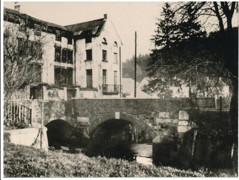
Abb. 16: Textilfabrik an der Wolfsfurth.
