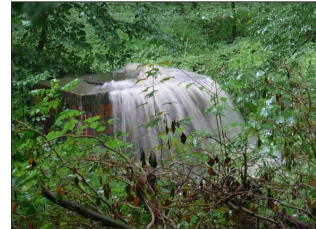
Abb. 62: Die Kanalisation schafft die Wassermassen nicht mehr. Wald an der Grenze zu Herzogenrath.
