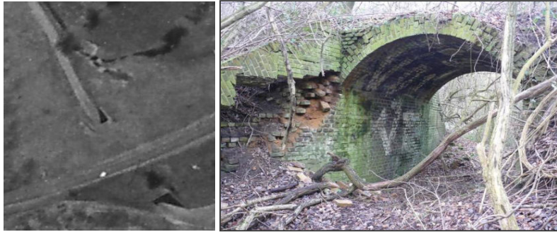
Abb. 42: Bahndamm mit Unterführung am Steingässchen. Die Unterführung liegt unterhalb des Jüdischen Friedhofs am Steingässchen und ist heute zugewachsen. Ausschnitt Luftbild 1944, KuAWu.
