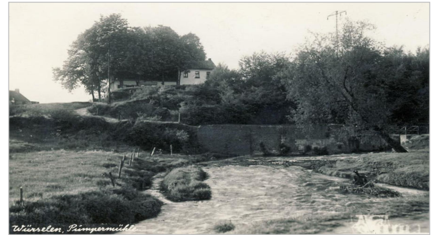
Abb. 11: Pumpen Häuschen, Vorkriegsaufnahme.
