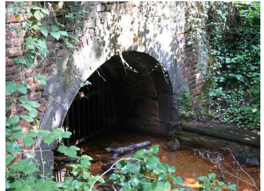
Abb. 31: Mundloch und Haus am Knopp – Ausbau im Jahr 1837, Haus von 1846.
