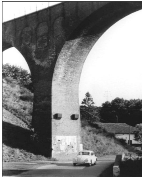
Abb. 38: Viadukt an der Teut.
